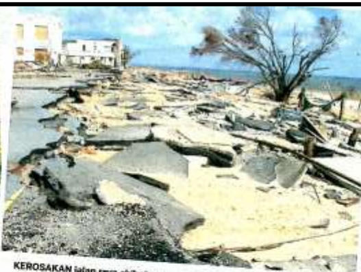
KEROSAKAN jalan raya akibat pusuan ribut.
